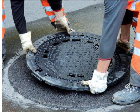
11 Einsetzen der selbstnivellierenden Abdeckung
