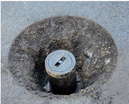
04 Fertiger konischer Ausbau mit neuer Schieberkappe
