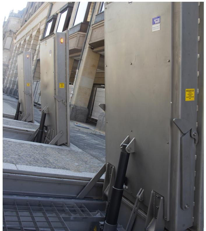
Beispielhafte Darstellung mit zusätzlichem Handhebelventil für die Notöffnung mit Blasespeicher
