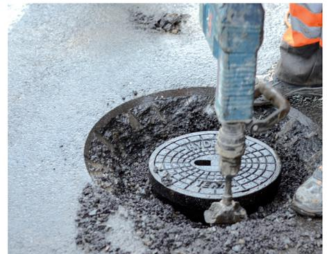
06 Lagenweiser Aufbau und Verdichten des Kaltmaterials
