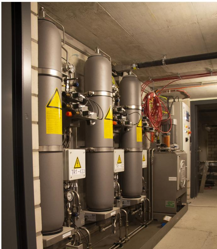
Steuerung mit Aggregat und Blasespeicher in einem Schaltschrank
