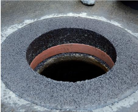
10 Fertiger Aufbau nach Herausnahme der Einbauhilfe
