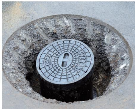
05 Fertiger konischer Ausbau mit neuer Hydrantenkappe
