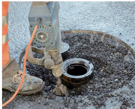
05 Lagenweiser Aufbau und Verdichten des Kaltmaterials
