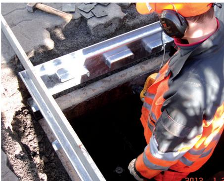
07 Ausrichten der Schachtabdeckung
