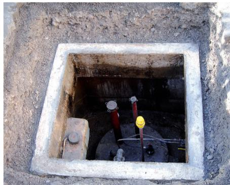
05 Schacht vorbereitet für Einsatz der neuen Abdeckung
