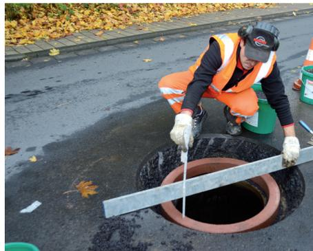
05 Fertiger konischer Ausbau mit neuem Adapterring
